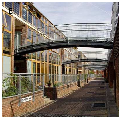
Imagem 1: O condomínio BedZED
