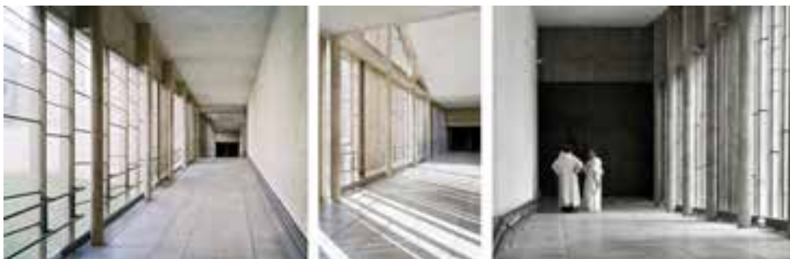
Ilustração 14 - Circulação: panos ondulatórios nos “conduits” do Convento Santa Maria de La Tourette. Oliver Martin-Gambier, 2004 (Adaptado a partir de] Fondation Le Corbusier, [s.d])
