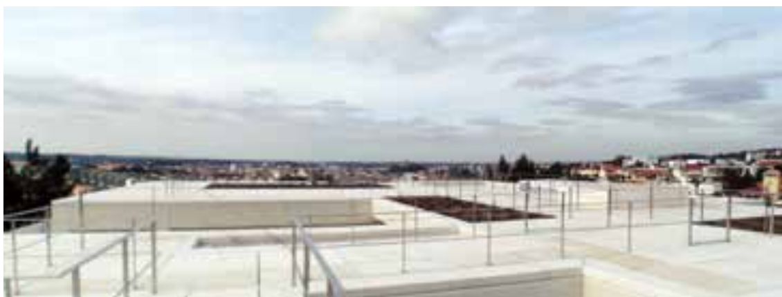
Ilustração 63 - Panorâmica da cobertura com as guardas metálicas em evidência. (Ilustração nossa, 2012)
