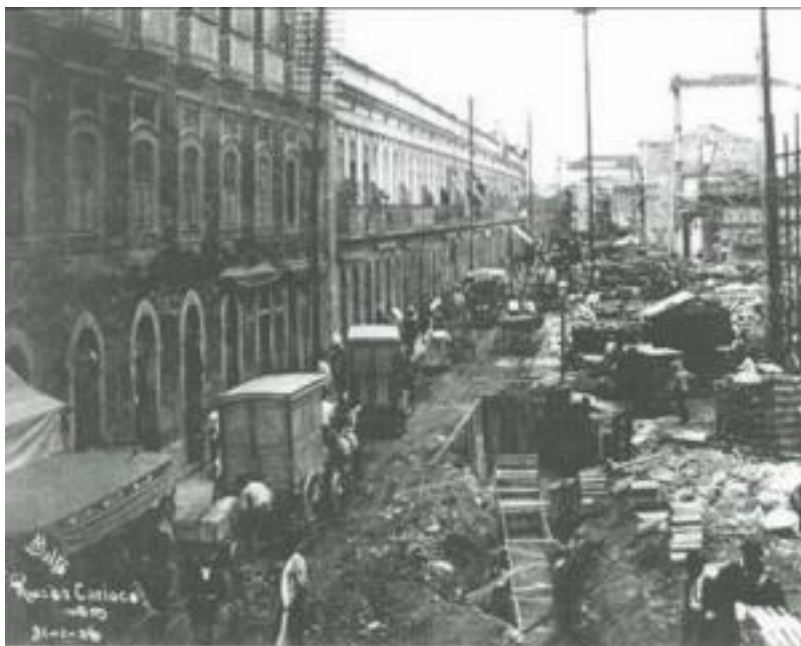
Ilustração 4 – Alargamento da Rua da Carioca. Os imóveis do lado direito foram demolidos, 1906 (Arquitetando (a), 2007)
