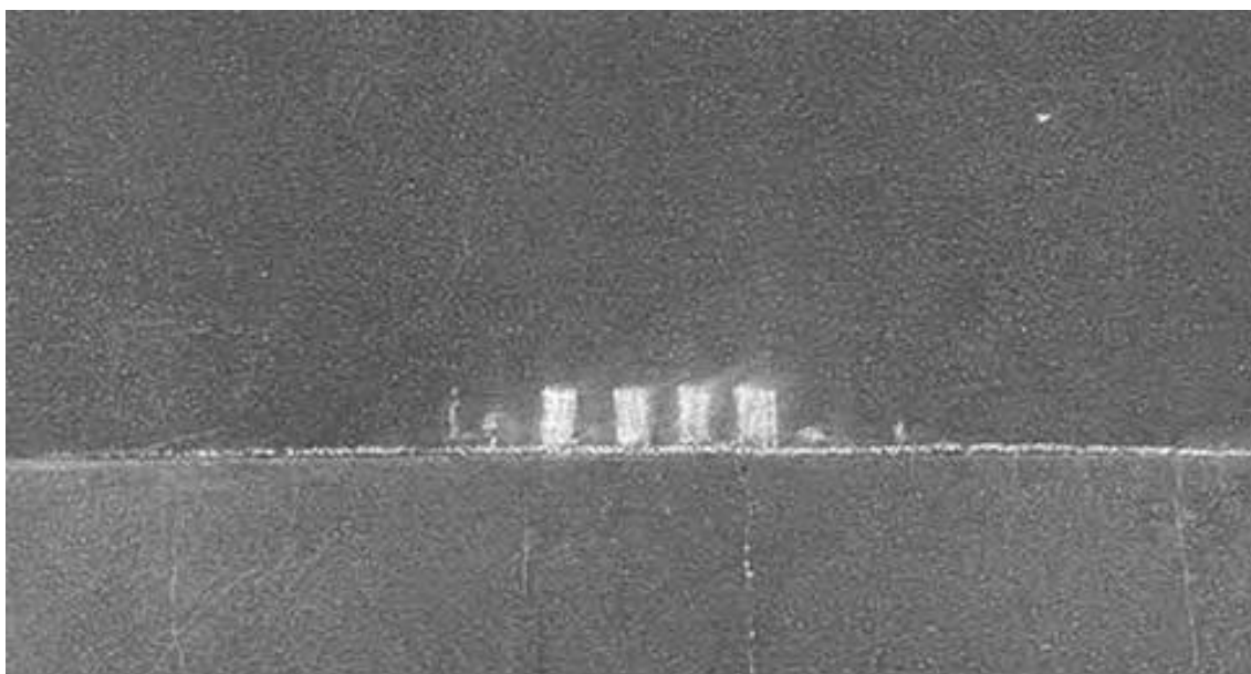
Ilustração 10 - Quatre édifice en vue nocturne, FLC 30.304 (Moreira, 2008, p. 64)
