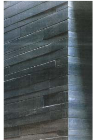
Fig.31 - Pormenor da estereotomia dos blocos de pedra
