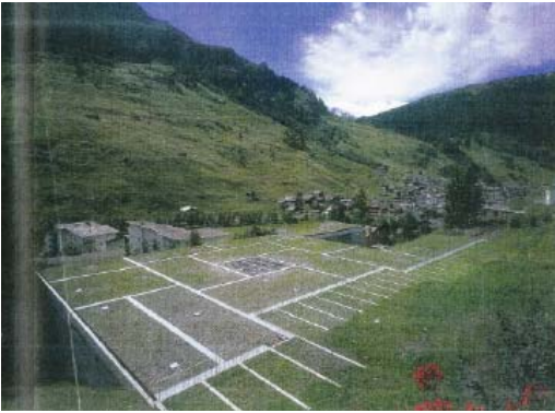
Fig. 3 - Cobertura do edifício, acontinuação da montanha, e a geometria dos contornos dos blocos
