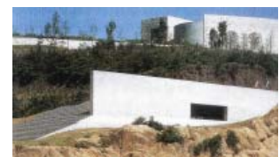
Fig.37 - Perspectiva a partir de baixo para a escadaria e museu, sendo visível a reentrância existente no plano lateral da escadaria
