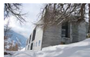
Fig. 19 - Perspectiva lateral do edifício
