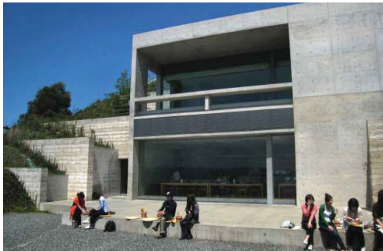
Fig. 64 - Perspectiva da única fachada do edifício
