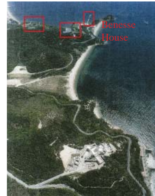
Fig. 36 - Fotografia aérea onde é visível em primeiro plano a construção do Chichu, e ao fundo a Benesse House
