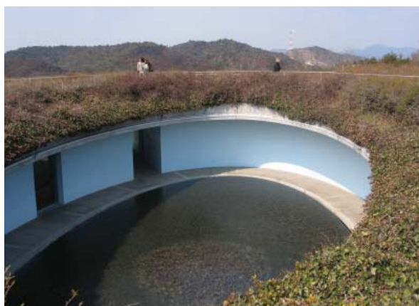
Fig. 33 - Perspectiva do interior da elipse, a partir da cobertura da mesma
