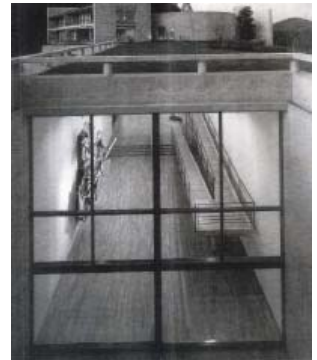
Fig. 58 . Perspectiva da galeria principal a partir da guarda do terraço rebaixado
