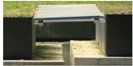
Fig. 22 e 23 - Pormenores da cobertura do edifício, entradas de luz da piscina interior com os candeeiros e detalhe da junção da cobertura dos blocos de pedra
