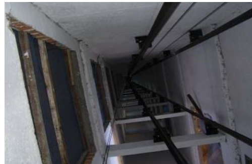
Figura 13: Fixação de GcR na estrutura da caixa de elevadores
