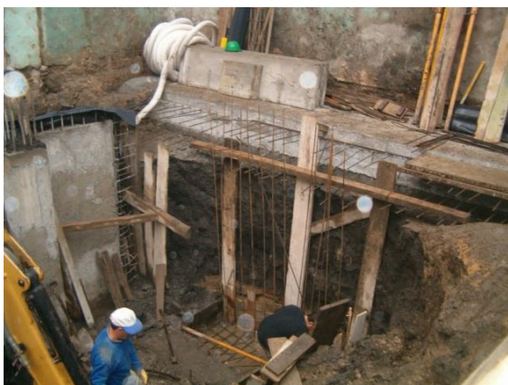
Figura 38: Armação de ferro para execução de sapata
