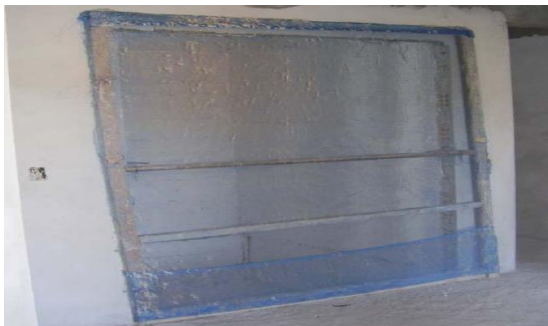
Figura 14 e 15: Sistema de protecção com encerramento total da abertura
