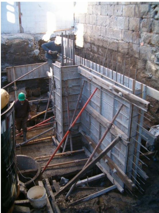
Figura 30: Execução do muro de suporte
