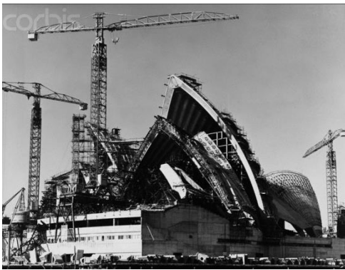
Figura 16: Ópera de Sydney, Austrália, em construção Junho de 1996.
