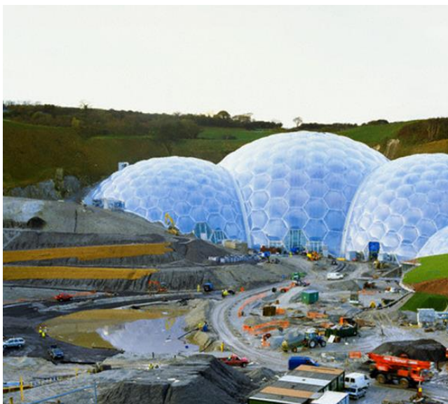
Figura 7: Construção do “Eden Project”. Bodelva, Engleand, UK.
