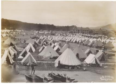
Figura 10 - Acampamento de refugiados, São Francisco. (fonte: http://livingsta.hubpages.com/hub/1906-San-Francisco-Earthquake )
