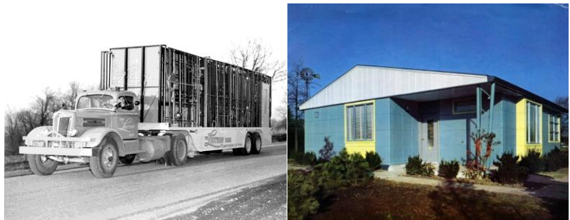
Figura 19 - Transporte e montagem - Lustron House
