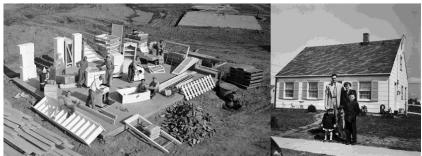
Figura 20 - : Montagem - Levittown houses
