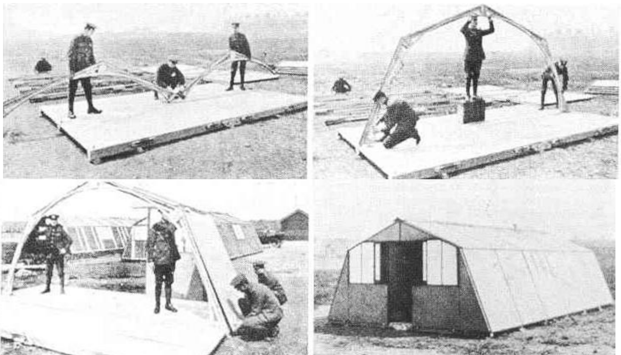
Figura 12 - - Montagem da tenda - "Weblee Portable Hut"
