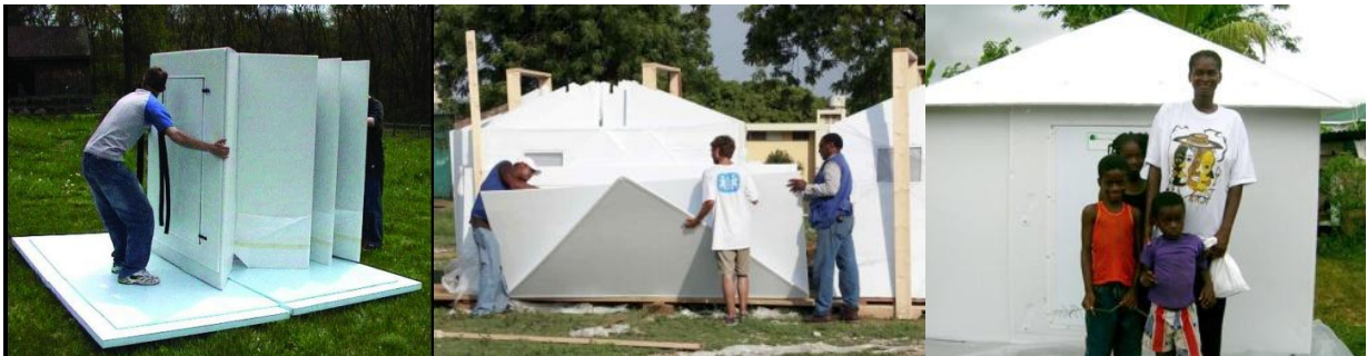
Figura 30 - A construção de uma unidade “Global Village helters”
