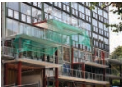
Ilustração 154 – Decorrer dos processos de instalação da estrutura modular. (Lacaton & Vassal, 2015, p. 232)
