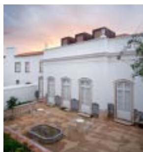
Ilustração 165 – Fachada Nascente da Casa da Escrita, que dá para um pátio acessível através do 1º piso. (Guerra, 2011)
