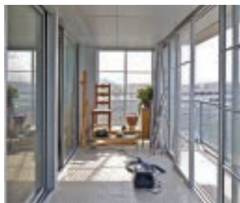
Ilustração 152 – Interior de um dos jardins de inverno, anexados à fachada da torre. (Lacaton & Vassal, s.d.c)
