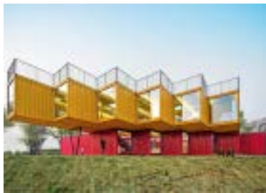
Ilustração 90 – Pavilhão temporário, em Shanxi, China, construído com base em 12 contentores. Projeto de 2015, do atelier de Pequim, People's Architecture Office. (Frearson, 2016)
