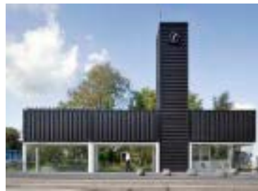
Ilustração 91 – Estação de comboios de Barneveld Noord, projeto de 2011, dos NL Architects, que utilizaram contentores marítimos para criação de espaço e distribuição do programa. (Davis, 2013)
