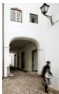
Ilustração 164 – Rua do Loureiro, no local em que atravessa o edifício. (Ribeiro e Guedes, 2016)
