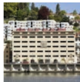
Ilustração 118 – “Douro's Place”, edifício de habitação e comércio, fruto da reconversão de um armazém frigorífico de bacalhau, Carlos Prata. (Prata, s.d.)
