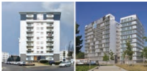
Ilustração 161 – Transformação de uma torre de apartamentos em Saint Nazaire, 2006-2014. (Lacaton & Vassal, s.d.e)
