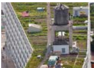
Ilustração 113 – A “Brooklyn Grange”, em Nova Iorque, resulta da reutilização adaptativa de uma fábrica do séc. XX, convertida em 2010 pelo atelier Bromley Caldari Architects num espaço de cultivo. (Kushner e Krichels, 2016, p. 122)
