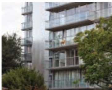
Ilustração 151 – Vista exterior de uma das fachadas do edifício, após o projeto de transformação. (Lacaton & Vassal, s.d.c)
