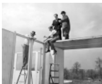
Ilustração 82 – W. Gropius e K. Wachsman, construção da “Packaged House”. (Harvard Art Museums, 2016)
