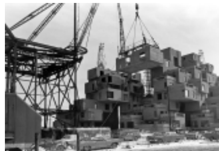
Ilustração 86 – Momento da fase de construção do complexo habitacional modular “Habitat”, em 1967. (Frearson, 2014)
