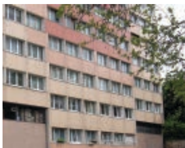
Ilustração 146 – Uma das fachadas existentes. (Lacaton & Vassal, s.d.c)
