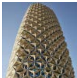
Ilustração 100 – Nas torres “Al Bahr” a equipa de projeto procurou reduzir os efeitos da radiação solar, e com base num elemento vernacular árabe, foi desenvolvido um sistema de fachada composto por mecanismos autónomos responsivos, que se fecham e abrem, durante o dia, relativamente à posição do sol. (Stevens, 2014)
