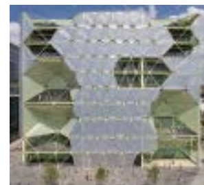
Ilustração 101 – As paredes exteriores do “Media-ICT” revelam uma superfície composta por almofadas insufláveis ETFE (etileno tetrafluoretileno). Um conjunto de sensores determina a quantidade de ar que entra e sai das almofadas, alterando a opacidade, permitindo filtrar a luz que penetra na fachada. (Fortmeyer e Linn, 2014, p. 40; Kushner e Krichels, 2015, p. 149)
