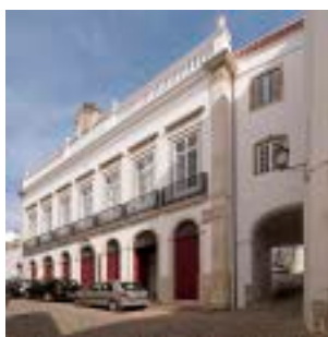
Ilustração 163 – Fachada da Casa da Escrita, junto à Rua João Jacinto, onde fica a entrada principal. (Ribeiro e Guedes, 2016)
