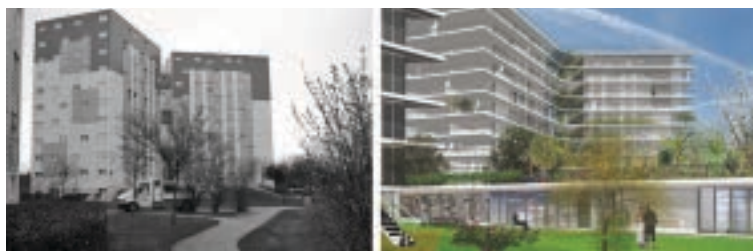
Ilustração 141 – Proposta de transformação de um edifício de habitação em Trignac, incluída na obra “PLUS”. (Lacaton & Vassal, s.d.b)
