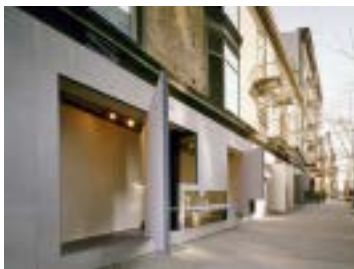
Ilustração 97 – Steven Holl e Vito Acconci distribuíram uma série de painéis articulados, ao longo da fachada da galeria, com base numa configuração inovadora: quando os painéis estão fixos, na posição aberta, a fachada “dissolve-se” e o espaço interior expande-se para o passeio. (Steven Holl Architects, s.d.b)
