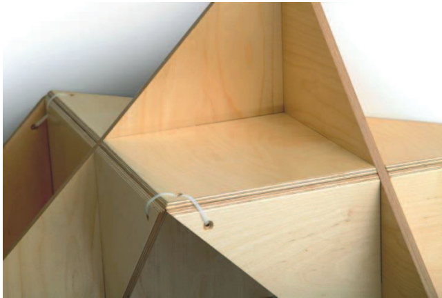
Figura 46 – Sistema de fixação T.SHELF .
