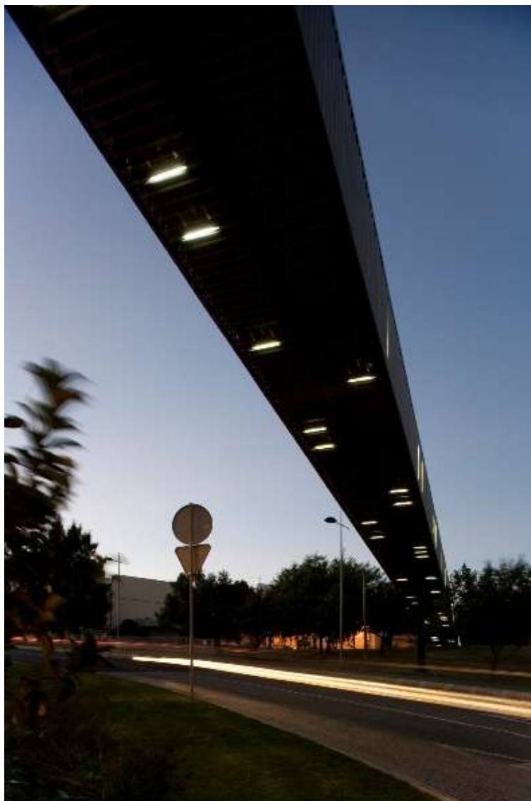
Ilustração 84 - Perspectiva exterior e inferior nocturna - Dissimulação dos pontos de apoio pelo posicionamento da iluminação exterior. (Arruda, fotografia cedida por Miguel Arruda, 2012)
