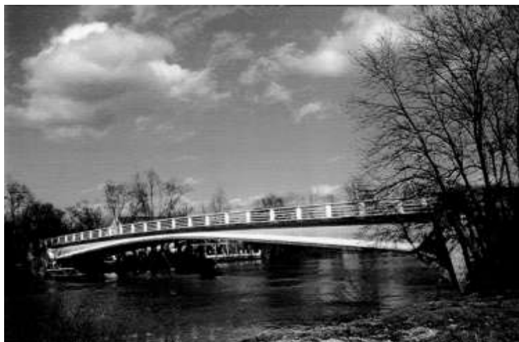
Ilustração 44 – Pont Annet por Eugène Freyssinet, uma das cinco pontes em pré-esforço sobre o rio Marne, construída entre 1947 e 1950. (Bennett, 1999, p. 211)
