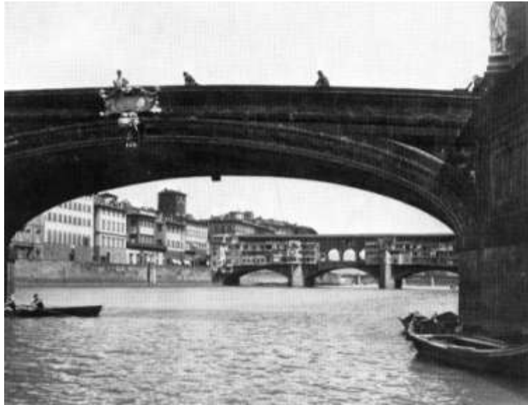
Ilustração 27 – Pormenor de arco abatido da Ponte Santa Trinità em Florença, construção de 1569. (Leonhardt, 1982, p. 75)
