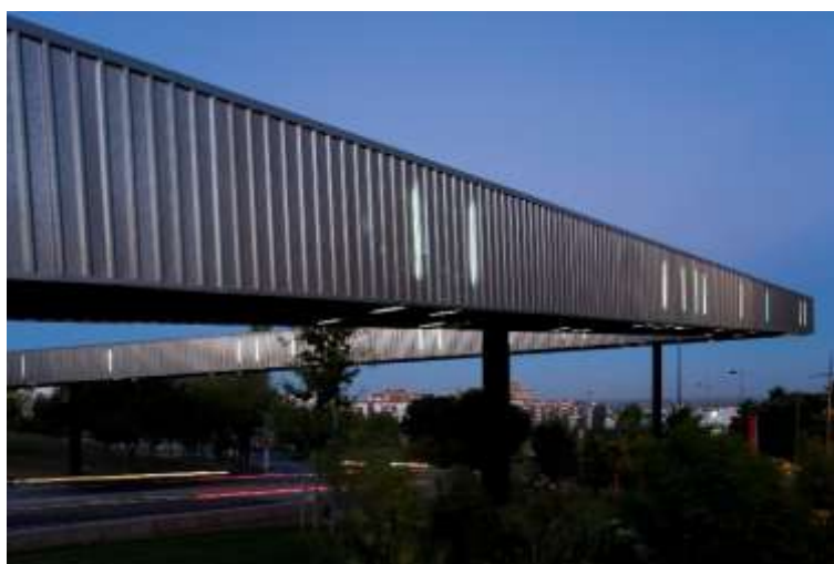
Ilustração 83 - Perspectiva exterior e inferior - Três pontos de apoio visíveis. (Arruda, fotografia cedida por Miguel Arruda, 2012)
