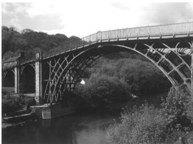
Ilustração 33 – Ponte de Coolbroakdale, construída com cinco perfis semicirculares. (Browne, 1996, p. 29)
