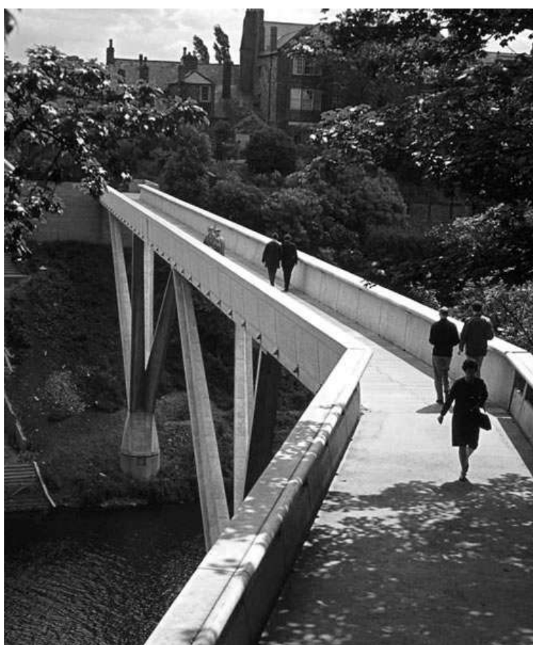
Ilustração 48 – Percurso pedonal acesso às instalações da Universidade Kingsgate, Durham por Ove Arup. (Arup, 2012)
