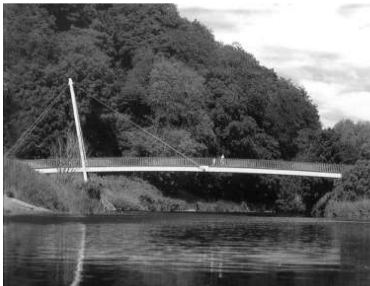
Ilustração 40 - Ponte de Durham, construída por Ove Arup em Inglaterra, de 1974. (Brown, 1996, p. 129)
