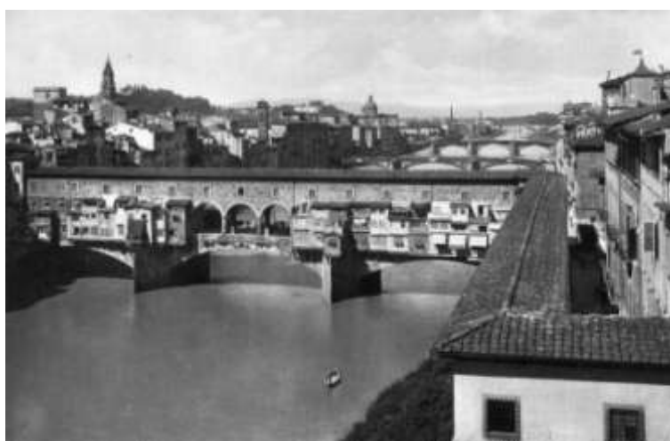
Ilustração 21 – Ponte Vecchio, Florença, composta por três arcos abatidos estruturais (Leonhardt, 1982, p. 74)
