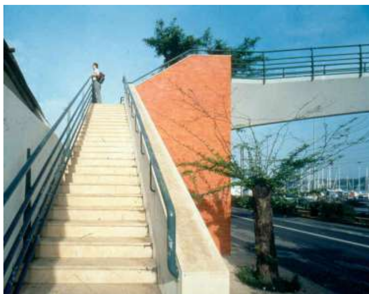
Ilustração 62 – Perspectiva ao acesso Norte á estrutura de atravessamento. (Tainha, fotografia cedida por Manuel Tainha, 1993)
