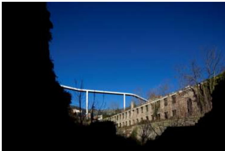
Ilustração 72 - Perspectiva da estrutura de atravessamento sobre as antigas instalações industriais de transformação de lanifícios. (Graça, 2012)
