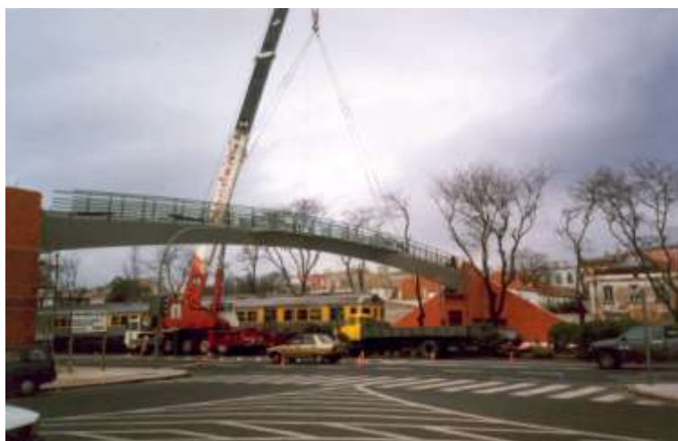
Ilustração 60 - Posicionamento da estrutura metálica de atravessamento. (Tainha, fotografia cedida por Manuel Tainha, 1992-1993)
