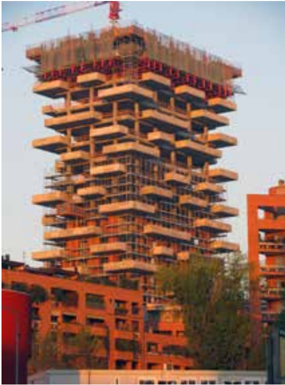
Ilustração 78 – Uma das Torres em Construção. (CTBUH, s.d.)
