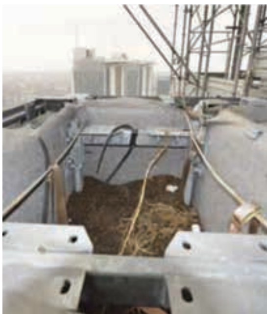
Ilustração 84 – Vista do interior do dispositivo de contenção com a tela de impermeabilização e a chapa protetora. (Giacomello, 2015, p. 17)
