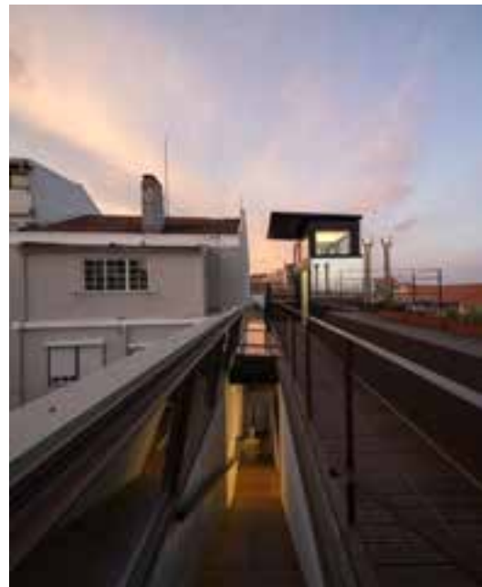
Ilustração 53 – Acesso à Cobertura. (Basulto D. e., 2012)
