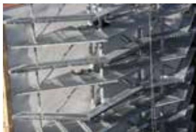
Ilustração 113 – Estrutura metálica. (Mazzocchi, 2012)
