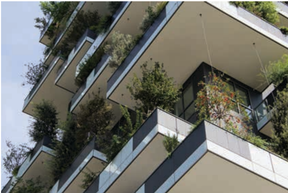
Ilustração 93 – Vista inferior de um dos edifícios. (Stevens, 2014)
