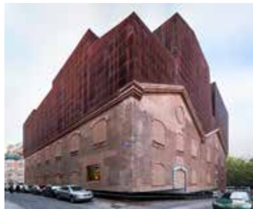
Ilustração 32 – Edifício reabilitado. (Bescós, 201?)
