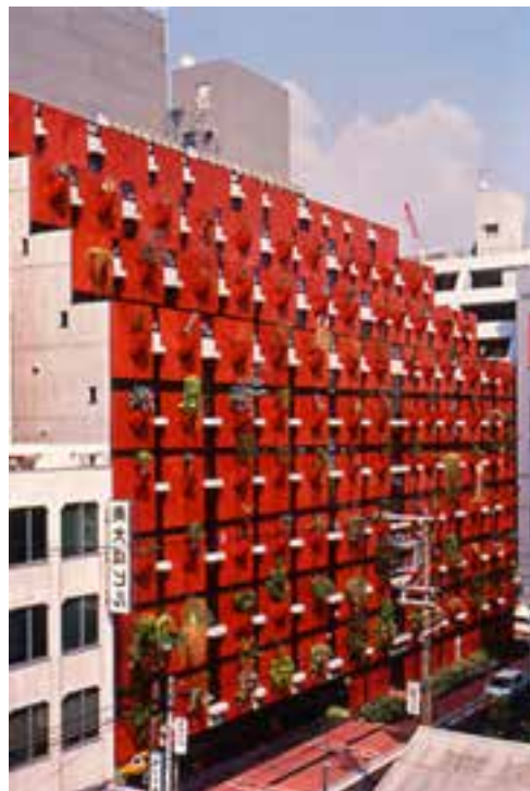
Ilustração 105 – Edifício na sua totalidade. (Pesce, n.d.)
