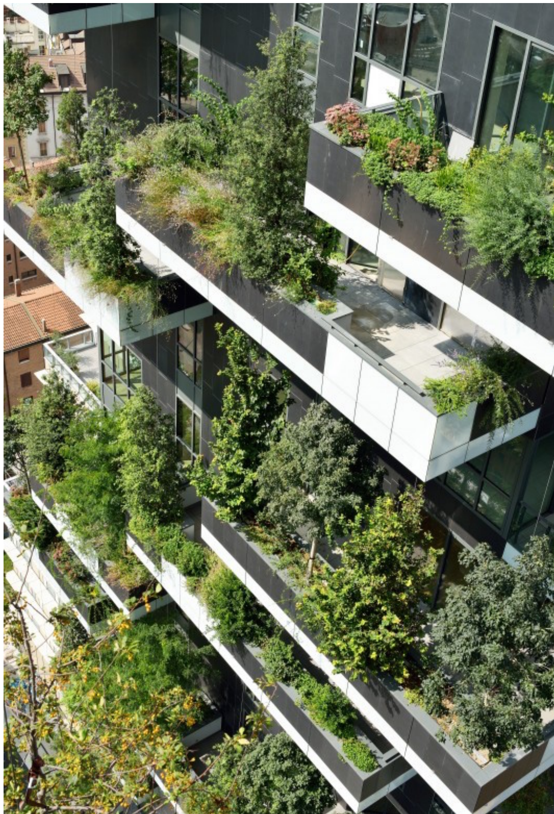
Ilustração 66 – Vista superior da fachada de um dos edifícios. (CTBUH, s.d.)
