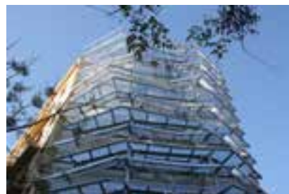
Ilustração 114 – Estrutura metálica. (Mazzocchi, 2012)
