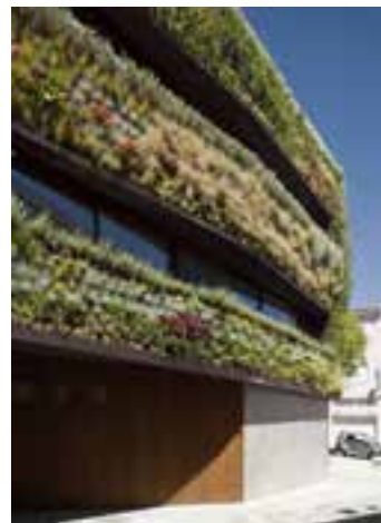
Ilustração 48 – Fachada principal. (FG+SG, 2012)
