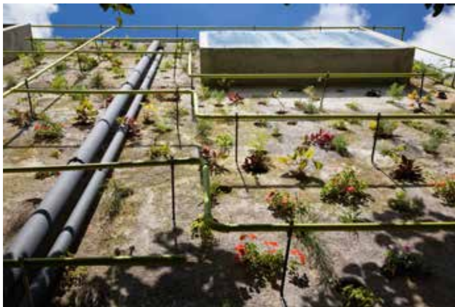
Ilustração 99 – Fachada do Edifício. (Duran & Fajardo, 2010, p. 53)
