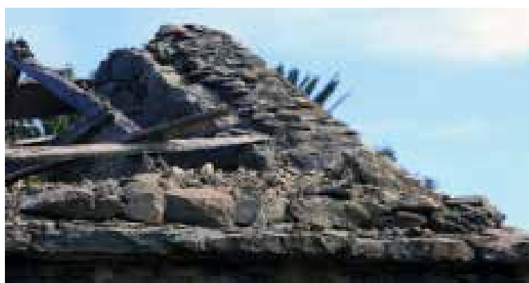
Ilustração 176 – Composição da cobertura e beiral do palheiro. (Ilustração nossa, 2016).
