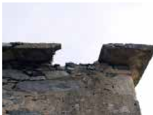
Ilustração 54 – Beiral da casa de salão com cobertura de 4 águas. (Ilustração nossa, 2016).
