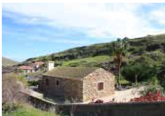
Ilustração 246 – Construção recente com cobertura idêntica a salão. (Ilustração nossa, 2016).
