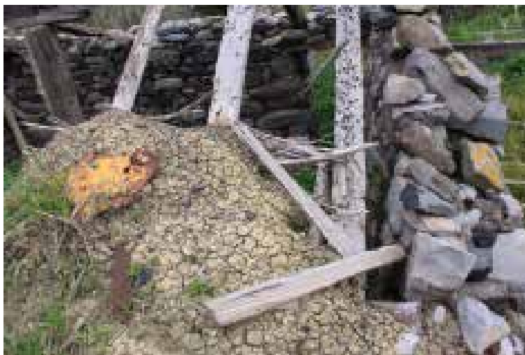
Ilustração 271 – Ruína. Pormenor da cobertura de salão. (Ilustração nossa, 2016).
