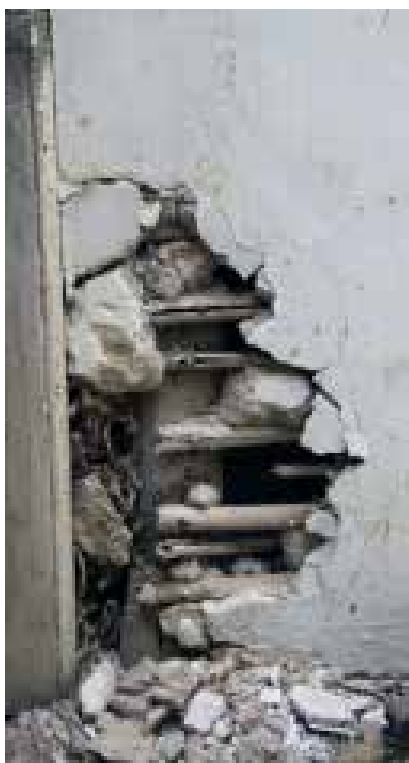
Ilustração 102 – Detalhe da parede divisória da casa de salão. (Ilustração nossa, 2016).
