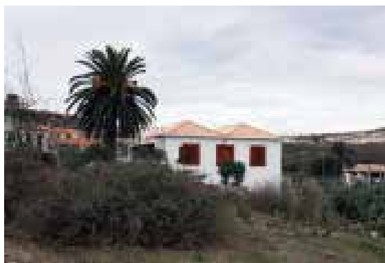
Ilustração 31 - Casa complexa com telhados múltiplos recuperada (Ilustração nossa, 2016).
