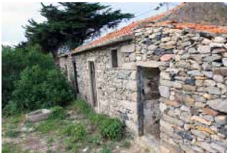
Ilustração 187 – Fachada Sul da habitação. (Ilustração nossa, 2016).
