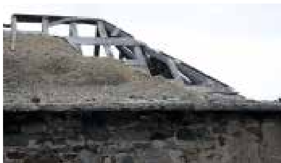
Ilustração 98 – Cobertura com ripagem da casa de salão – vista exterior. (Ilustração nossa, 2016).
