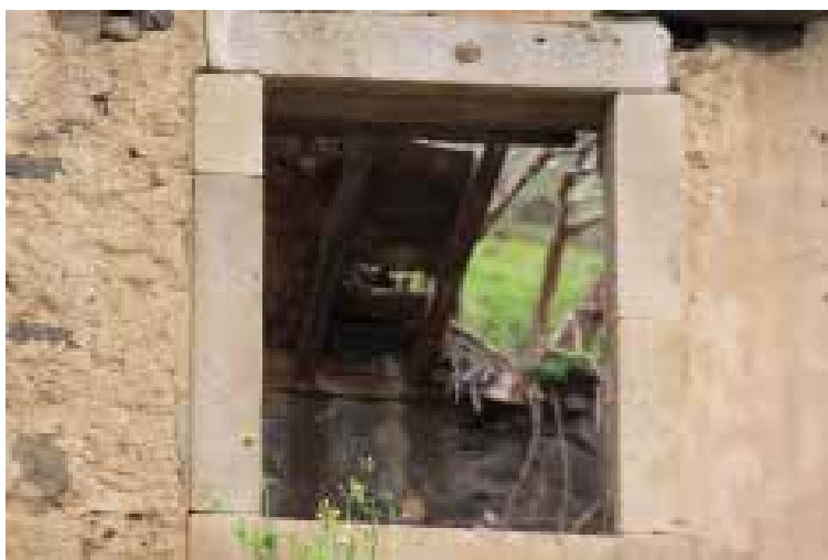
Ilustração 275 – Ruína. Pormenor da janela de peito. (Ilustração nossa, 2016).
