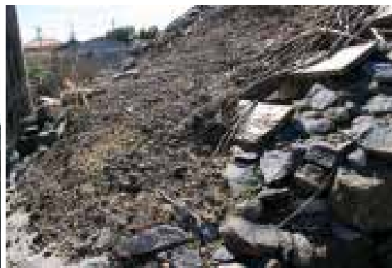
Ilustração 174 – Pormenor da cobertura do palheiro. (Ilustração nossa, 2016).
