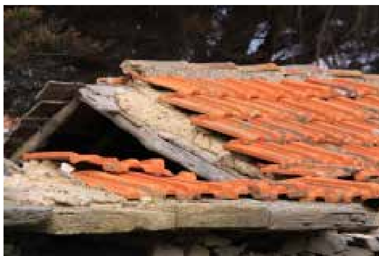
Ilustração 189 – Vista exterior da cobertura de salão com telha. (Ilustração nossa, 2016).
