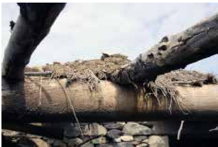
Ilustração 207 – Pormenor do toro central de madeira e dos caibros da cobertura de salão. (Ilustração nossa, 2016).
