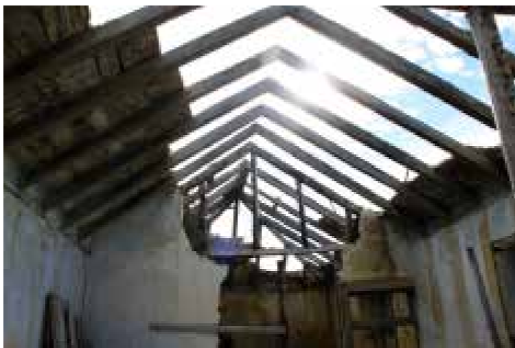
Ilustração 134 – Estrutura da cobertura de salão. (Ilustração nossa, 2016).
