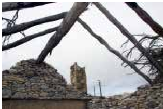
Ilustração 111 – Vista interior da cobertura de salão do palheiro e estábulo. (Ilustração nossa, 2016).
