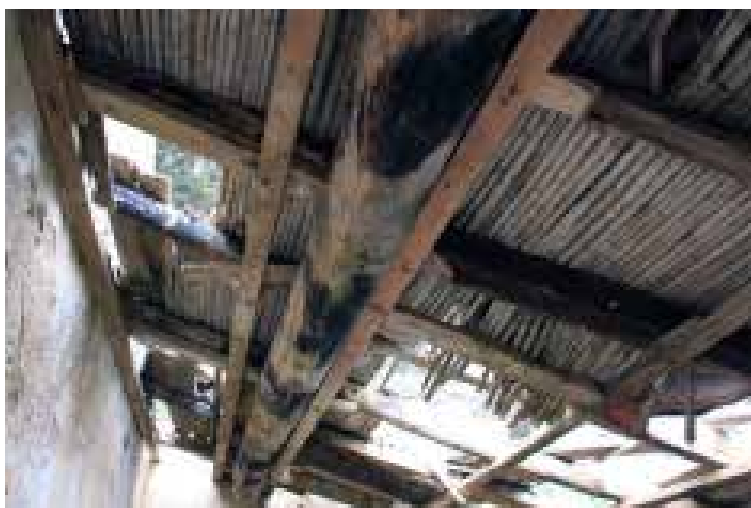
Ilustração 53 – Cobertura com forro de canaveira. (Ilustração nossa, 2016).
