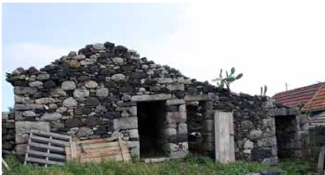
Ilustração 203 – Fachada Oeste do conjunto edificado do palheiro e estábulo. (Ilustração nossa, 2016).
