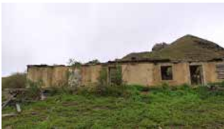
Ilustração 273 – Ruína. Fachada de habitação com cobertura de salão. (Ilustração nossa, 2016).
