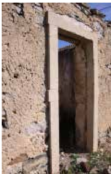
Ilustração 167 – Ombreiras da porta de entrada. (Ilustração nossa, 2016).
