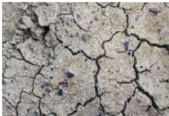
Ilustração 79 – Salão fendilhado. (Ilustração nossa, 2016).
