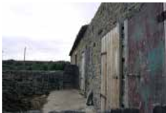
Ilustração 230 – Vãos de entrada da fachada Sul. (Ilustração nossa, 2016).
