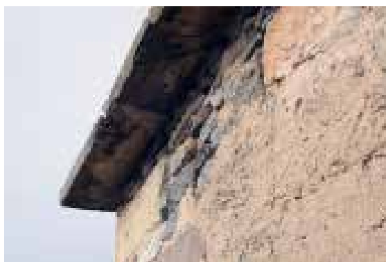
Ilustração 97 – Pormenor da cimalha da casa de salão. (Ilustração nossa, 2016).
