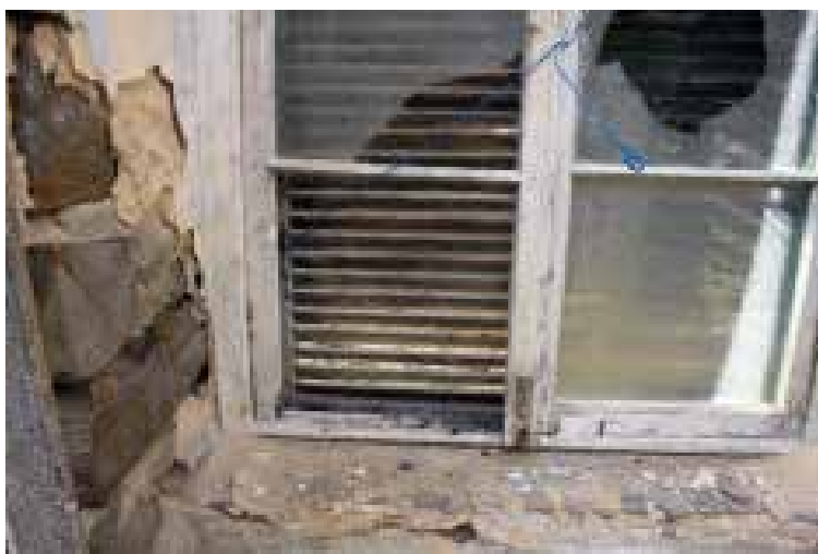
Ilustração 133 – Pormenor da caixilharia da janela e parede. (Ilustração nossa, 2016).
