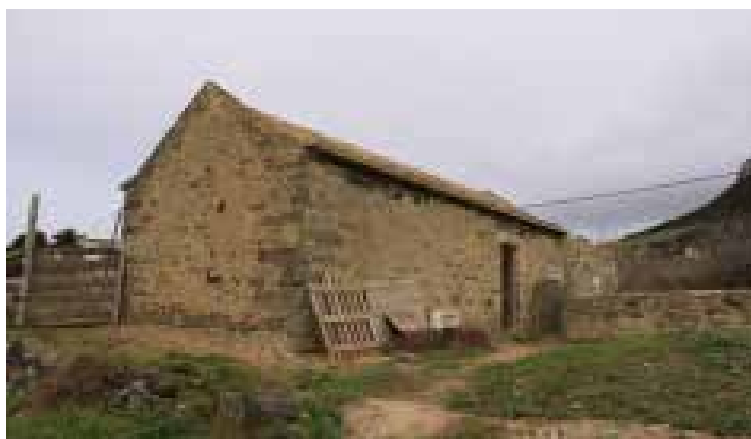
Ilustração 223 – Fachada Oeste e Sul do conjunto edificado. (Ilustração nossa, 2016).
