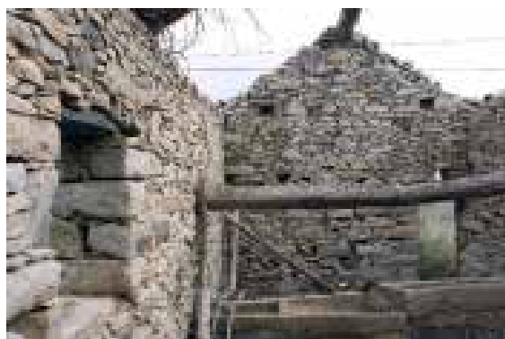
Ilustração 118 – Vista interior das fachadas Norte e Este do palheiro e estábulo. (Ilustração nossa, 2016).
