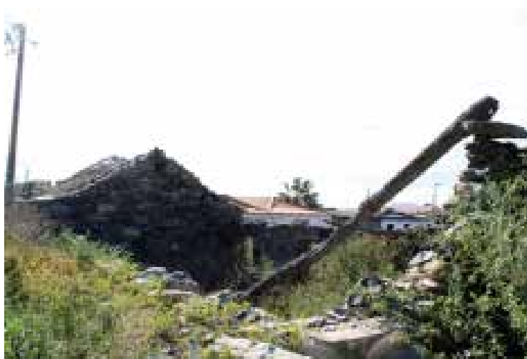
Ilustração 179 – Cobertura da edificação do palheiro e estábulo. (Ilustração nossa, 2016).
