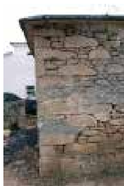
Ilustração 47 – Pormenor da parede exterior. (Ilustração nossa, 2016).
