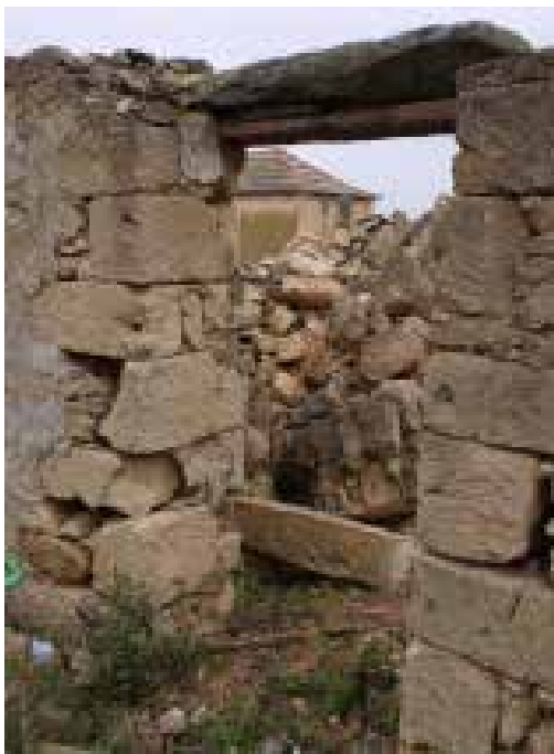
Ilustração 277 – Ruína. Pormenor da composição da parede de pedra aparelhada. (Ilustração nossa, 2016).
