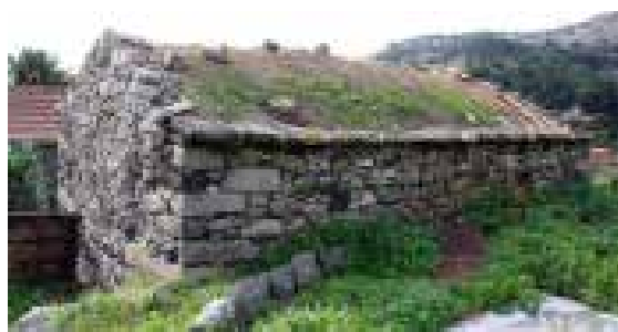
Ilustração 57 – Cobertura de salão. (Ilustração nossa, 2016).
