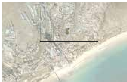
Ilustração 161 – Vista aérea geral do conjunto edificado do caso de estudo 3. (Google Inc, 2016).
