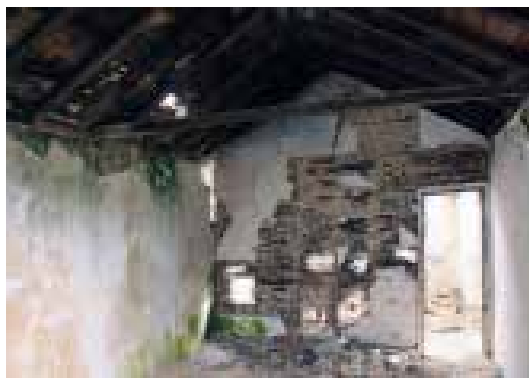
Ilustração 62 – Parede divisória da cozinha – quarto de dormir. (Ilustração nossa, 2016).
