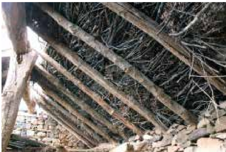
Ilustração 206 – Cobertura de salão no interior do palheiro e estábulo. (Ilustração nossa, 2016).
