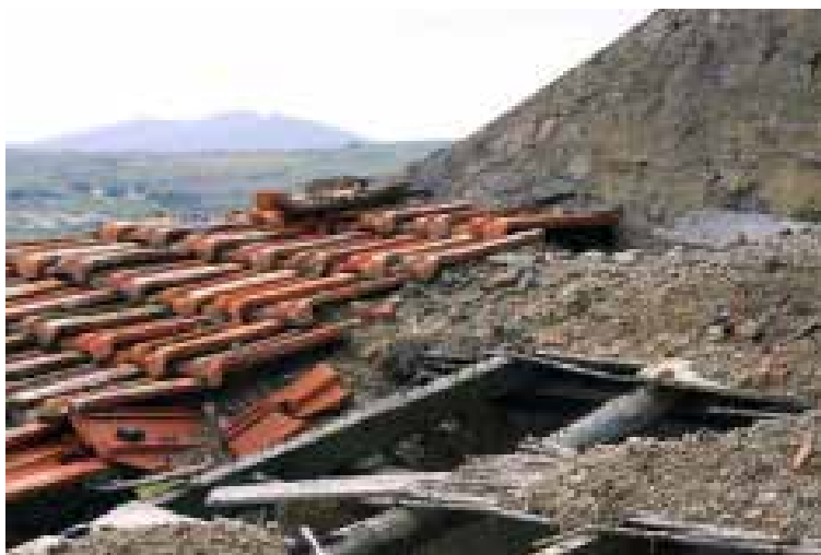
Ilustração 195 – Vista exterior da cobertura de salão com canaveira e telha. (Ilustração nossa, 2016).
