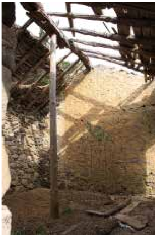
Ilustração 197 – Vista interior da cobertura do palheiro e estábulo. (Ilustração nossa, 2016).
