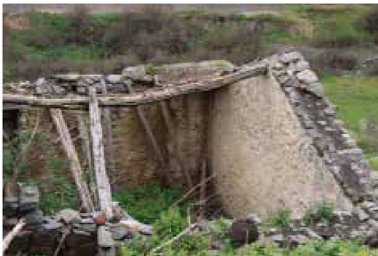
Ilustração 274 – Ruína. Pormenor da cobertura de salão. (Ilustração nossa, 2016).
