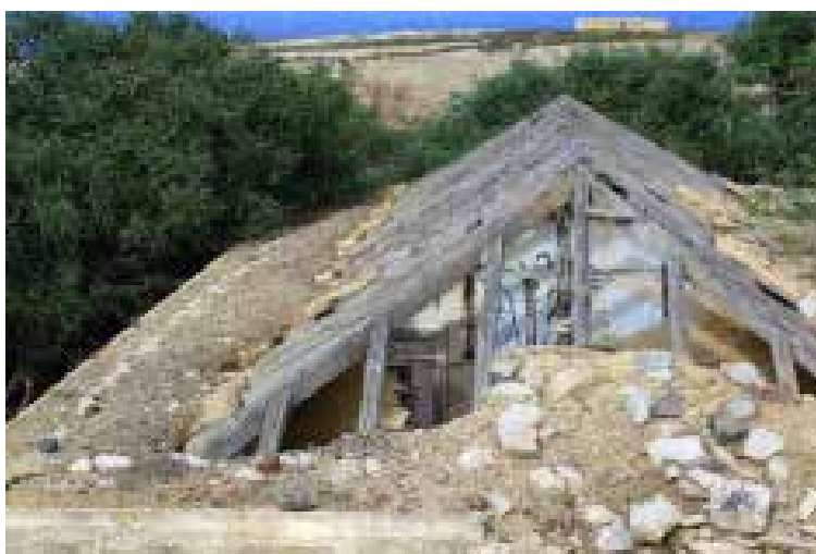
Ilustração 137 – Cobertura da casa de salão – Fachada Sul. (Ilustração nossa, 2016).
