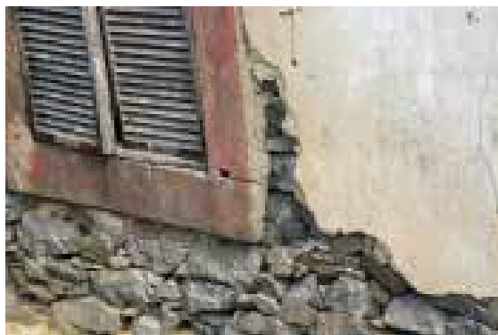
Ilustração 50 – Pormenor das ombreiras da janela em ocre vermelho. (Ilustração nossa, 2016).
