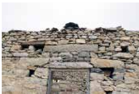
Ilustração 116 - Pormenor da padieira e caixilharia da porta de entrada do palheiro. (Ilustração nossa, 2016).
