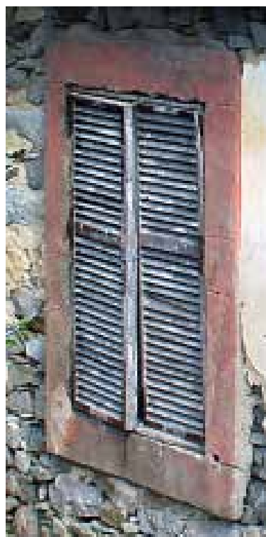
Ilustração 132 – Pormenor da ombreira da janela de peito da casa de salão. (Ilustração nossa, 2016).
