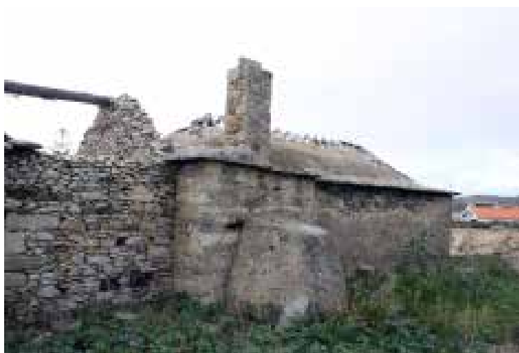
Ilustração 90 – Chaminé em pedra e saliência do forno em casa de salão. (Ilustração nossa, 2016).
