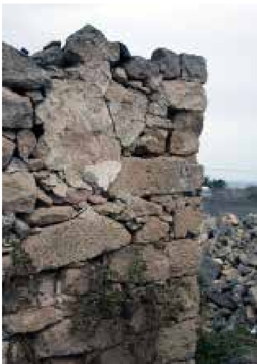
Ilustração 276 – Ruína. Pormenor da composição da parede de pedra aparelhada. (Ilustração nossa, 2016).
