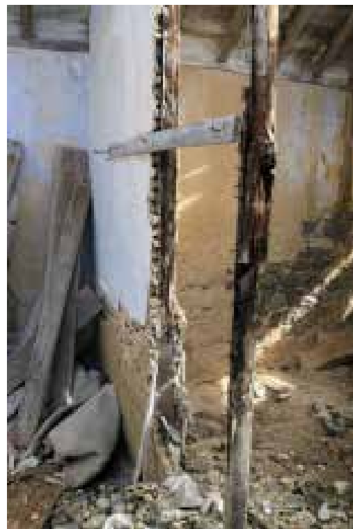
Ilustração 140 - Pormenor do tabique da parede divisória da cozinha – quarto de dormir. (Ilustração nossa, 2016).
