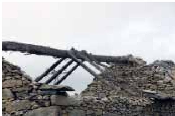
Ilustração 110 – Toro de madeira e caibros da cobertura de salão de palheiro e estábulo. (Ilustração nossa, 2016).
