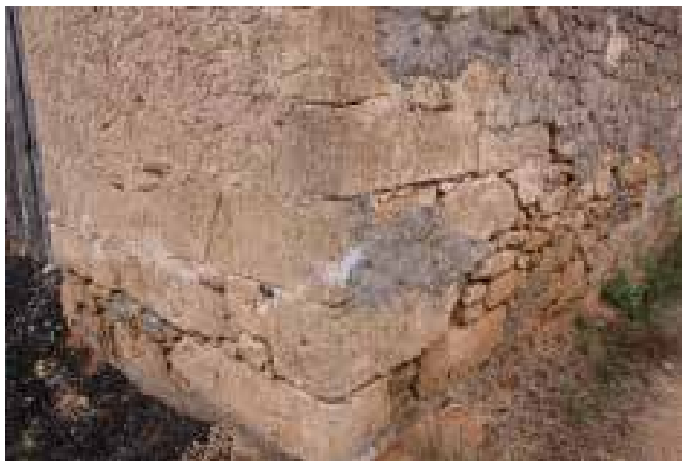
Ilustração 278 – Ruína. Pormenor da composição da parede de pedra aparelhada. (Ilustração nossa, 2016).
