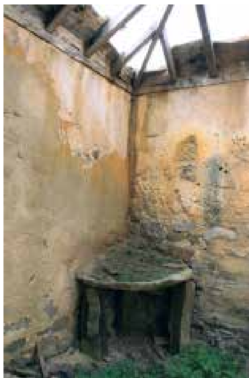
Ilustração 144 – Cisterna de água na cozinha da casa de salão. (Ilustração nossa, 2016).
