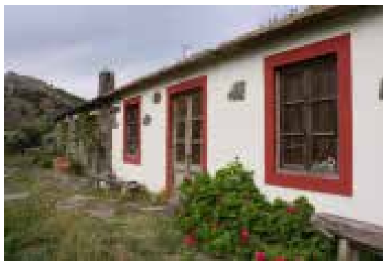
Ilustração 241 – Fachada principal da edificação (Ilustração nossa, 2016).
