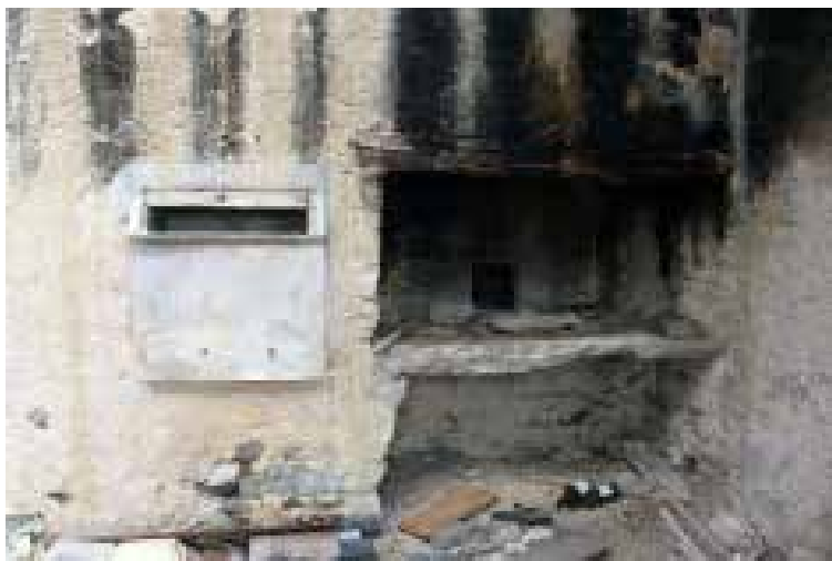
Ilustração 106 – Forno de cozinha da casa de salão. (Ilustração nossa, 2016).
