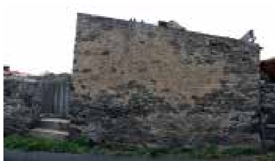
Ilustração 231 – Fachada Este do estábulo. (Ilustração nossa, 2016).
