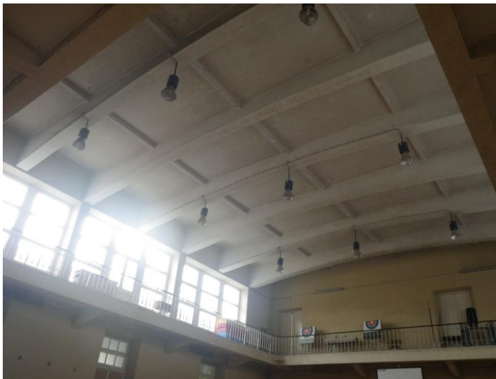
Ilustração 9 - Vista da estrutura aparente na cobertura do ginásio da EsMAVC (Ilustração nossa, 2013)
