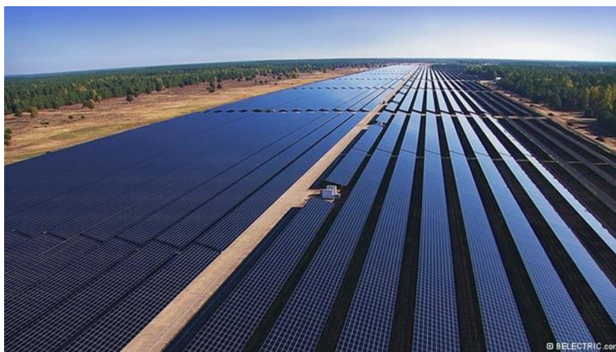
Ilustração 6 – Painéis fotovoltaicos em solo na Itália. (Can Stock Photo, 2013)
