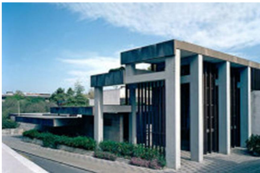
Ilustração 6 - Vista do edifício CAM. (Fundação Calouste Gulbenkian, 2015)
