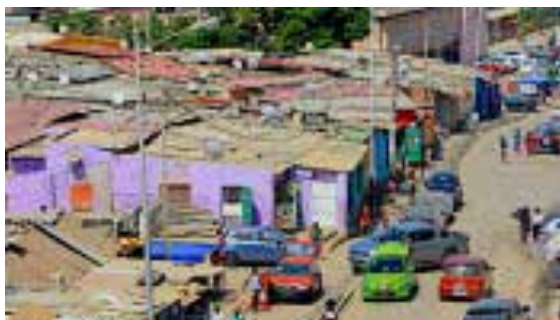
Ilustração 41 – Habitações com paredes de cimento rebocado e pintado, e coberturas em chapas de zinco, algumas seguras com pedras. (Ilustração nossa, 2015)
