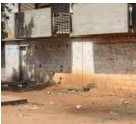
Ilustração 180 – Encerramento do espaço das garagens com bloco de cimento na fachada Norte. (Ilustração nossa, 2015)
