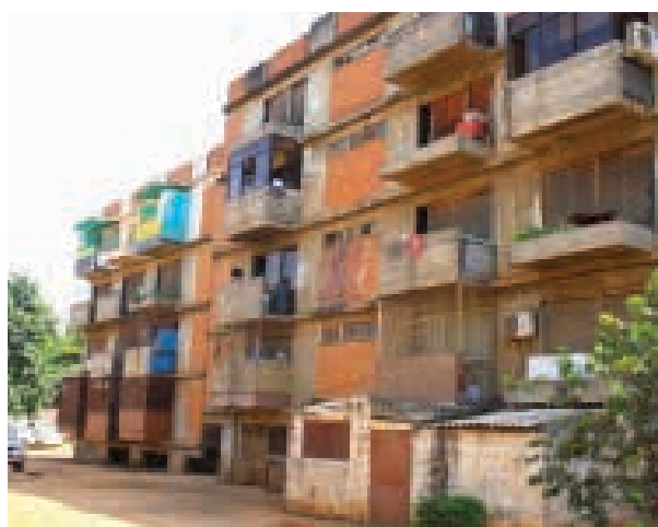
Ilustração 181 – Anexo construído no piso térreo. (Ilustração nossa, 2015)
