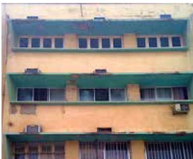
Ilustração 53 – Fachada de edifício com elementos horizontais de protecção solar. (Ilustração nossa, 2014)
