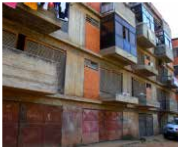
Ilustração 179 – Encerramento do espaço das garagens com portão na fachada Sul. (Ilustração nossa, 2015)
