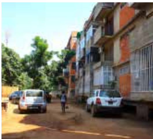
Ilustração 178 – Encerramento das varandas com grades e vidro. (Ilustração nossa, 2015)
