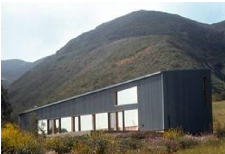
Ilustração 68 - Casa atelier de Ron Davis, Los Angeles, vista exterior, Frank Gehry, 1968-72 (Davis, 2014)
