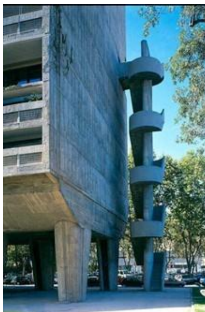
Ilustração 46 - Unidade de habitação de Marselha, escada exterior de acesso aos pisos intermédios, Le Corbusier, 1945 (Fondation Le Corbusier, 2015)
