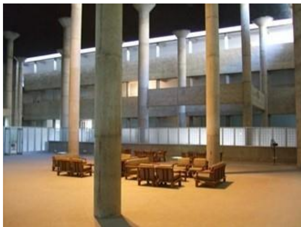
Ilustração 54 - Palácio da Assembleia, Chandigarh, sala principal, Le Corbusier, 1955 (Fondation Le Corbusier, 2015)
