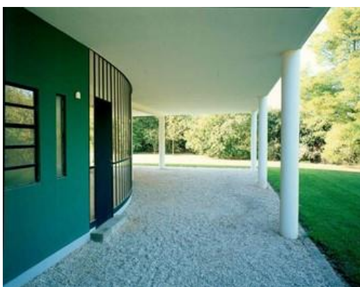
Ilustração 35 - Villa Savoye, Poissy, imagem do sistema de pilotis do edifício, Le Corbusier, 1928 (Fondation Le Corbusier, 2015)
