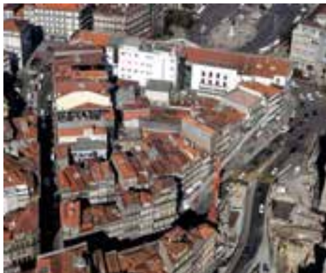
Ilustração 34 - Estado do Quarteirão das Cardosas antes da intervenção (PORTO VIVO, SRU, 2015)
