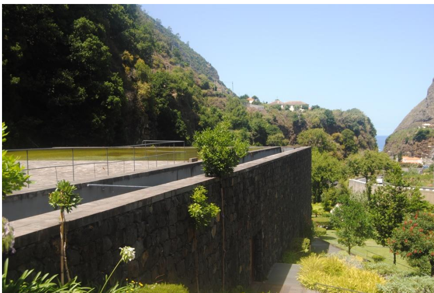
Ilustração 25 – Pavilhão de Vulcanismo muro em basalto (Ilustração nossa, 2015)
