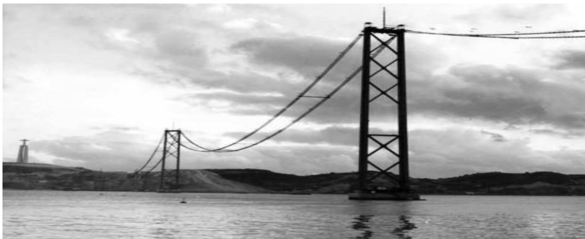
Ilustração 9 - Ponte 25 de Abril, na fase de construção. (História de Portugal, 2011)
