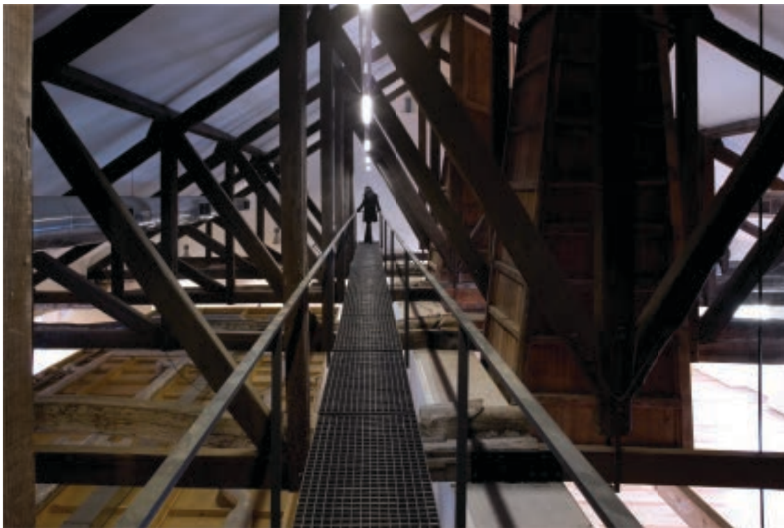
Ilustração 63 – Estrutura acessível da cobertura, CAV, fotografia de Fernando Guerra. (Ribeiro, 2015, 2015b).
