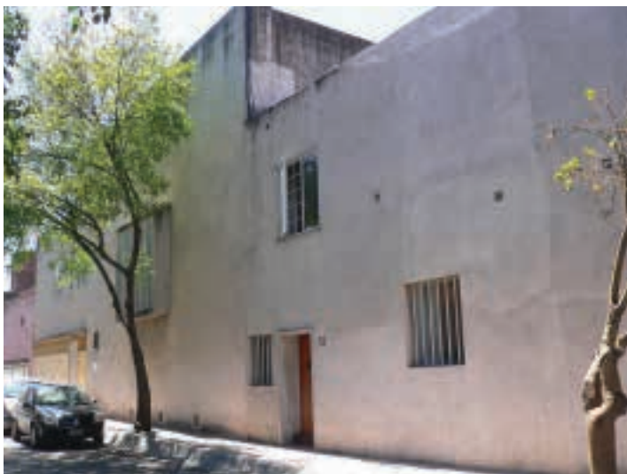
Ilustração 30 – Casa-Atelier Luís Barragán: Fachada, Luís Barragán, 1948. (Sveiven 2011).
