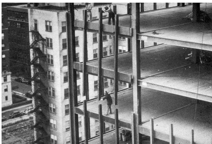
Ilustração 29 - Assemblagem da estrutura da fachada de um dos edifícios do lake shore drive, Hedrich-Blessing, 1950. (Carter, 2007, p. 47).
