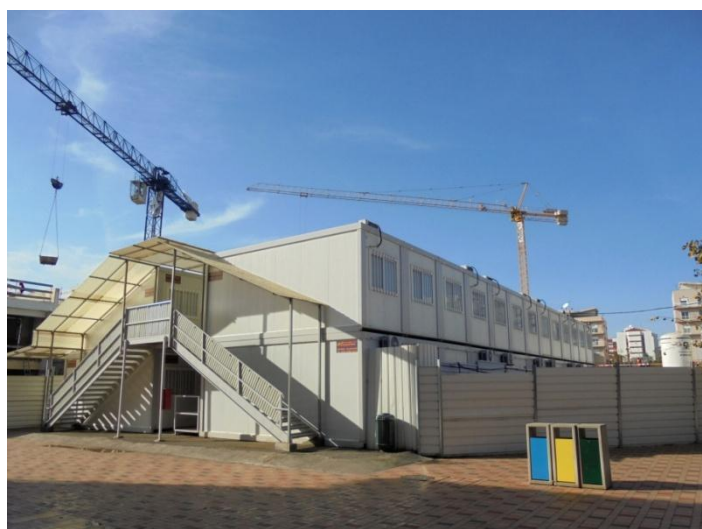
Ilustração 10 - Um dos blocos de contentores utilizados para o leccionamento de aulas. (Ilustração nossa, 2014)
