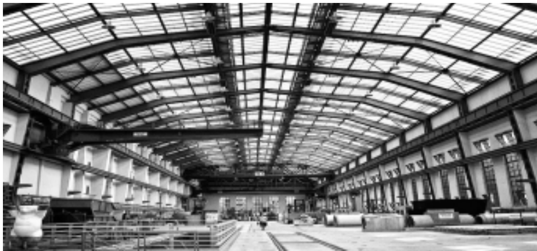
Ilustração 12 – Fábrica de Turbinas AEG (Berlim, Alemanha), projeto do Arqt. Peter Behrens. (d.teil, 2009)
