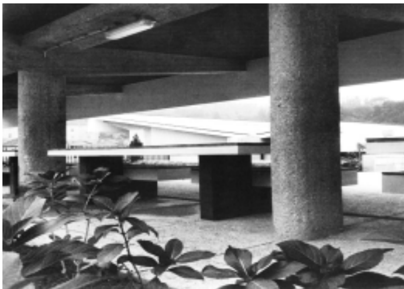
Ilustração 108 – Vista por baixo da cobertura, exibindo os pilares estruturantes em Y (Santa Maria da Feira, Portugal), projeto do Arqt. Fernando Távora (Távora, 1993)
