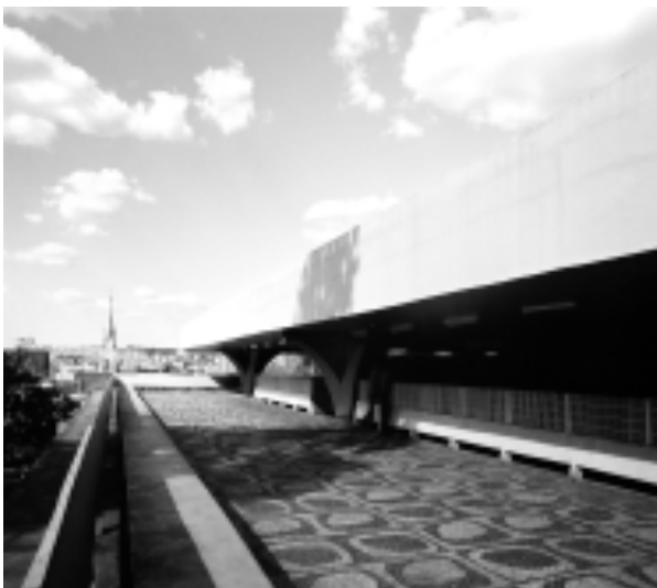
Ilustração 55 – Rodoviária de Jaú (São Paulo, Brasil), projeto do Arqt. Vilanova Artigas, gabriel sepe. (Igor Fracalossi, 2013)
