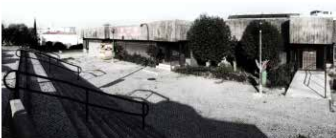
Ilustração 95 – Zona de entrada principal para os serviços e áreas administrativas (Olivais Sul, Lisboa), projeto do Arqt. Pedro Vieira de Almeida (Ilustração nossa, 2014)
