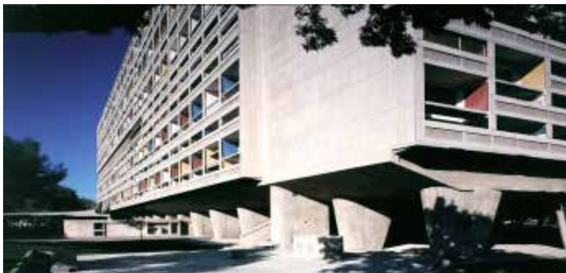
Ilustração 21 – Unidade de Habitação de Marselha (Marselha, França), projeto do Arq. Le Corbusier. (Fondation Le Corbusier, 2014)
