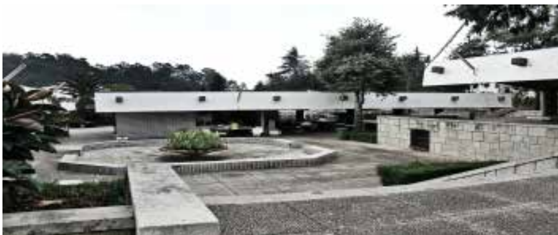
Ilustração 107 – Vista para o pátio central do Mercado Municipal Vila da Feira (Santa Maria da Feira, Portugal), projeto do Arqt. Fernando Távora (César Santos, 2014)
