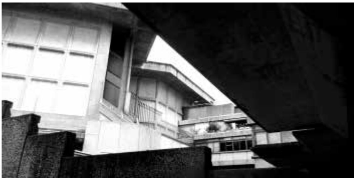
Ilustração 88 – Vista da entrada principal da Igreja do Sagrado Coração de Jesus (Lisboa, Portugal) projeto dos Arqts. Nuno Teotónio Pereira e Nuno Portas (Ilustração nossa, 2014)
