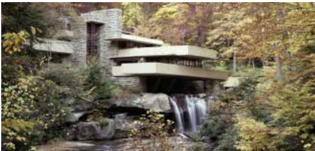
Ilustração 17 – Casa da Cascata (Pensilvânia, E.U.A), projeto do Arqt. Frank Lloyd Wright. (Adelyn Perez, 2010)
