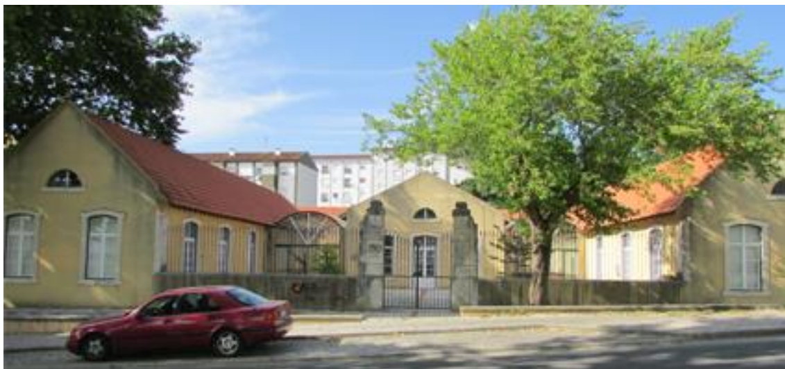
Ilustração 29 - “Edifício do Matadouro Municipal, atual Centro da Juventude”, André Barros. (Ilustração nossa, 2014)
