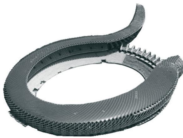
**Fig.8** - Novo estádio em Taiwan (Toyo Ito): 14 155m<sup>2</sup> de cobertura com 8 844 painéis fotovoltaicos gerando 1.14 GWh de electricidade por ano.
